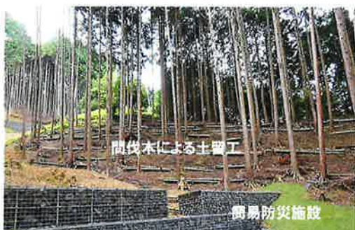
緊急防災林整備(溪流対策) (丹波市市島町)
